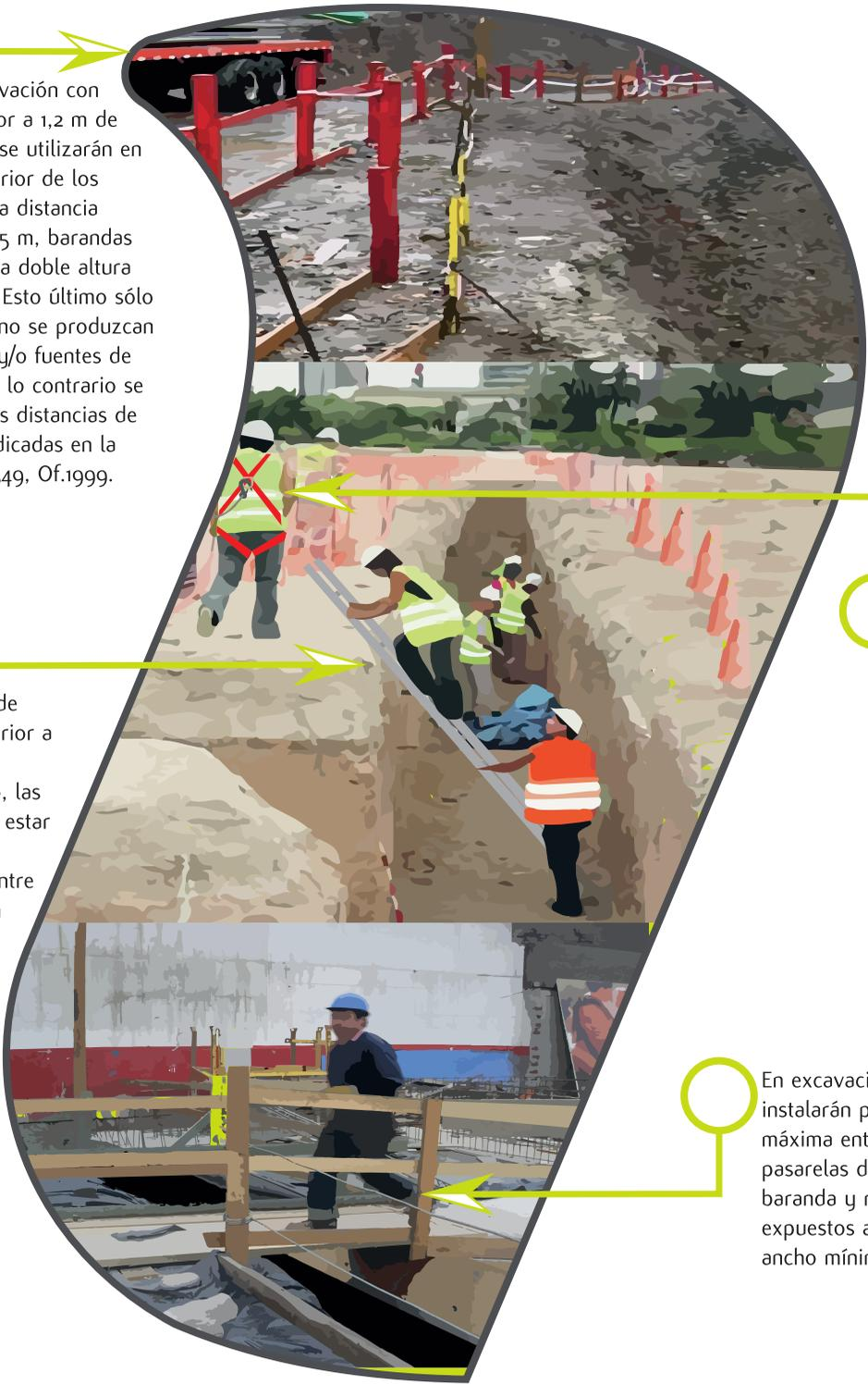
En toda excavación con altura superior a 1,2 m de profundidad se utilizarán en la parte superior de los taludes, a una distancia mínima de 0,5 m, barandas perimetrales a doble altura con rodapié. Esto último sólo en caso que no se produzcan sobrecargas y/o fuentes de vibración, de lo contrario se respetarán las distancias de seguridad indicadas en la norma NCh 349, Of.1999.
